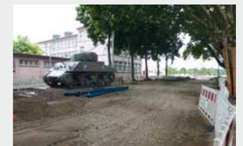
Rien n'arrêtera les extensions tram. Ici l'extension ligne D au Port du Rhin
