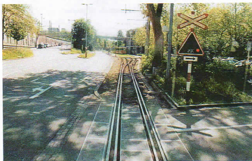
Photos : Max Mondon - Sur la ligne 17 du BLT à proximité du zoo de Bâle un exemple de voies entrelacées.
