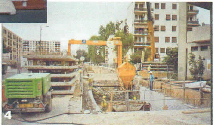
Photo 5 : le lit agrandi sera couvert par une dalle servant de plate-forme aux voies du tram.
