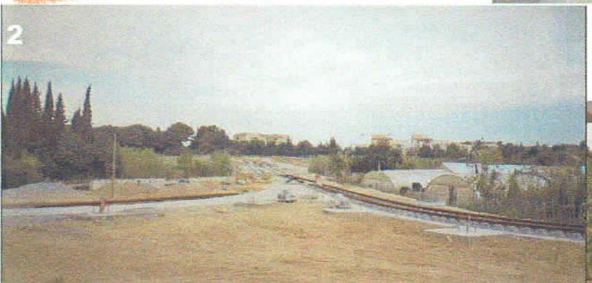
Photo 5 : le lit agrandi sera couvert par une dalle servant de plate-forme aux voies du tram.
