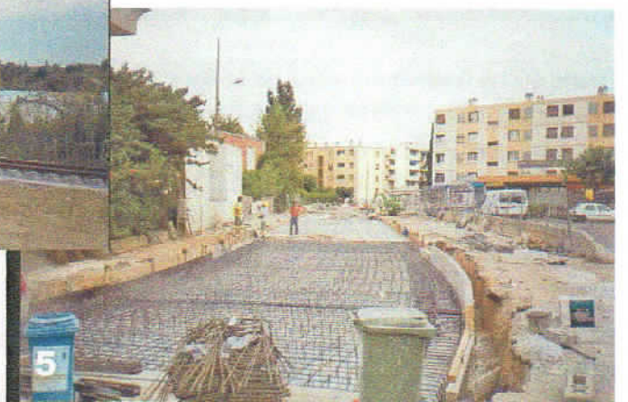
Photo 5 : le lit agrandi sera couvert par une dalle servant de plate-forme aux voies du tram.
