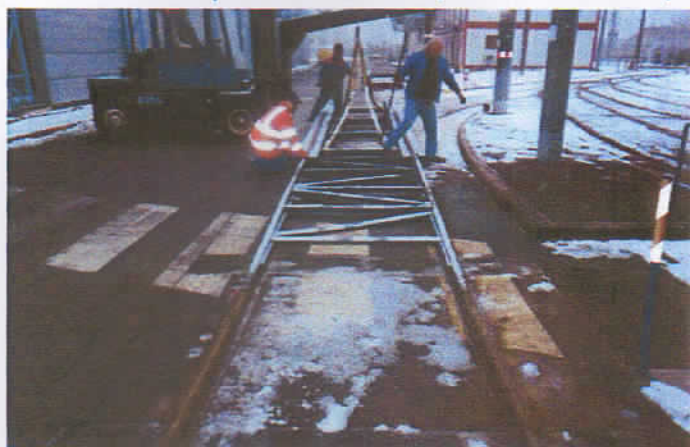
Il faut maintenant poser la rampe de déchargement.
