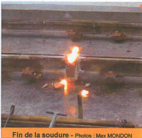
Fin de la soudure - Photos : Max MONDON
