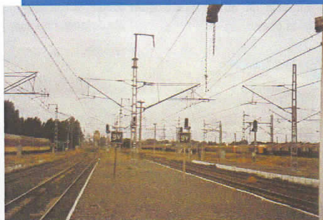
Electrification en 25000 Volts 50 Hz, du moderne et performant !
