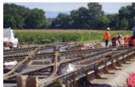
Pose du 1 er rail du tram Ouest
